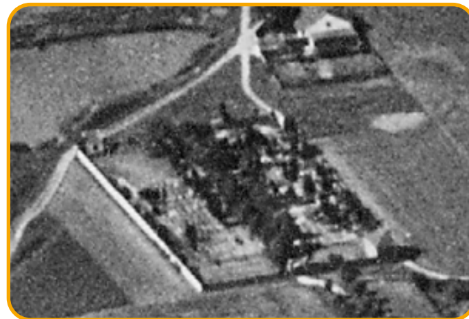
Auf diesem Ausschnitt aus einer vor 1930 entstandenen Luftbildaufnahme kann man die zweite Erweiterung von 1894 noch relativ gut erkennen.
