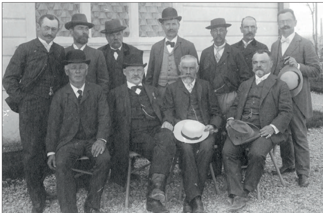
Zwei Ärzte, drei Bürgermeister und drei Vizebürgermeister auf einem Bild: In der ersten Reihe v. l. n. r. sitzend: Ferdinand Hausenberger (I, Bgm. 1879–82), Josef Müller (Vizebgm. 1888–1912), Franz Toyfl (II, Bgm. 1894–1912), Dr. Roderich Koralewski (Vizebgm. 1912–19 u. 1921–24). In der zweiten Reihe ganz links Johann Wiesmayer (II, Bgm. 1912–24), daneben Oberlehrer Franz Koprowsky und eventuell Eduard Toyfl (III); ganz rechts Lehrer und Gemeindevorstand Josef Kirchberger, daneben Paul Hausenberger (II, Vizebgm. 1882–84 u. 1885–88).
