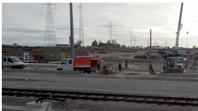
Foto Terminal: Das Baustellengelände Terminal Inzersdorf an der Landesgrenze (von der Pottendorfer Richtung Osten gesehen). In der Bildmitte ist der bereits teilweise überschüttete Tunnel Hennersdorf ersichtlich. Foto Johannisweg (ganz oben): Die Baustelle der künftigen Unterführung Johannisweg Anfang September 2015.
